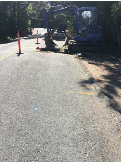
1. Dig pull pit
